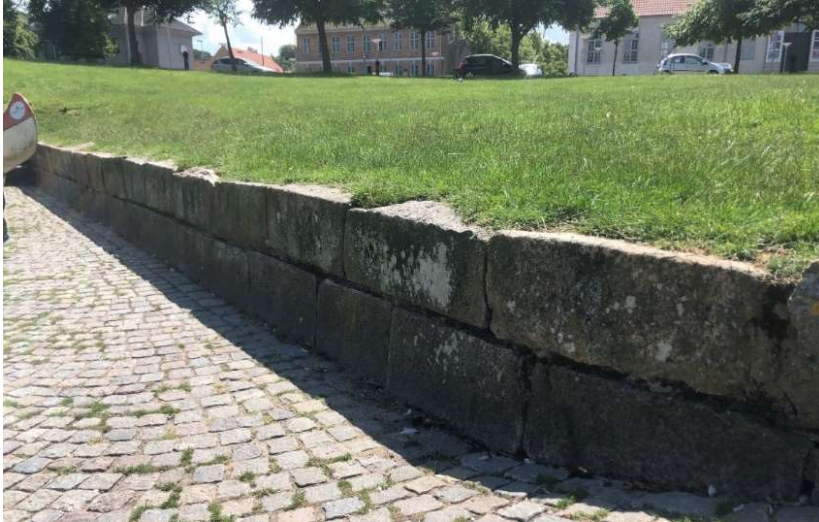
Granitkvader ved Mølledam i dag. Ny løsning anvender ligeledes kvader til kantning af kanalen. Kvaderne sættes i beton.
